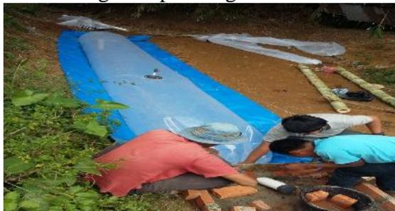
Gambar 11. Pembuatan digester biogas
