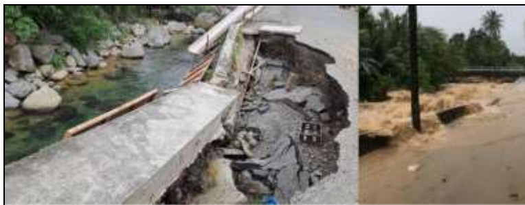
Gambar 1. Kerusakan jalan desa akibat banjir bandang di Sungai Guo
