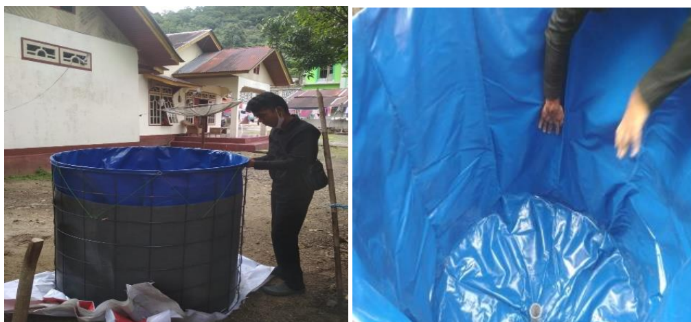
Gambar 2. Pembuatan Kolam Bioflok
