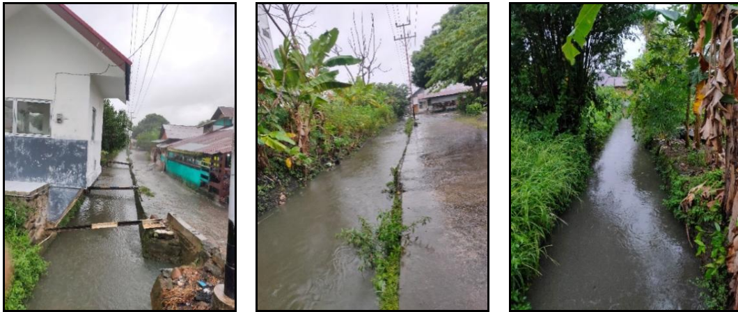
Gambar 2. Kondisi kanal saat cuaca hujan dan badai (21/09/2022)
