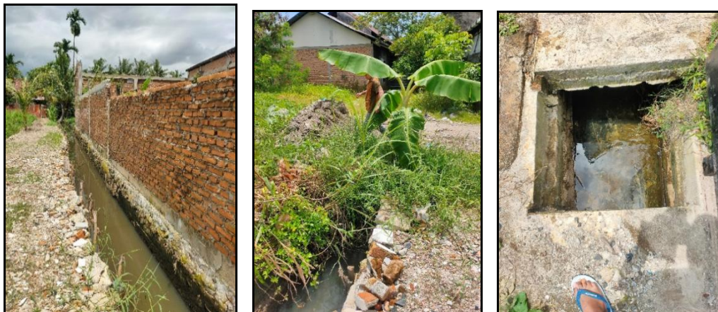
Gambar 5. Kondisi drainase yang awal lebarnya besar menjadi kecil karena pembangunan rumah yang berada di kampung tersebut
