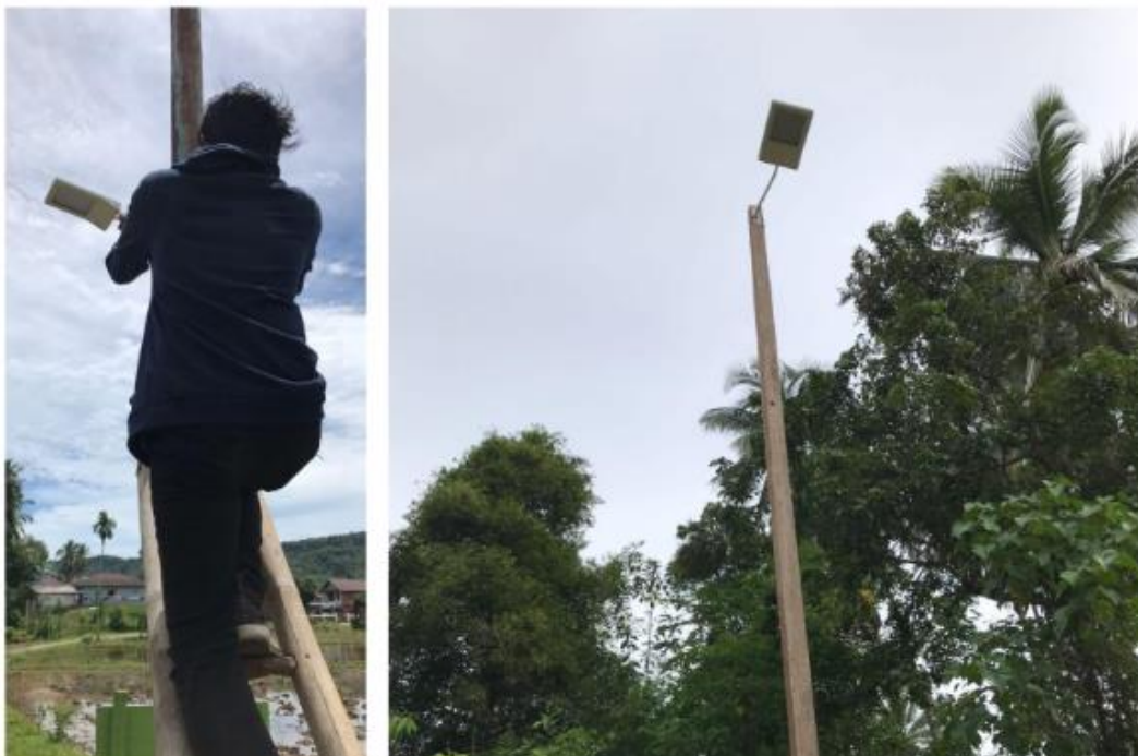
Gambar 5. Pemasangan Lampu PJU
